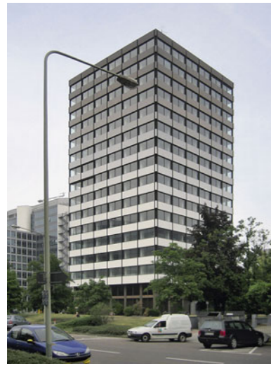
Der Büroturm vor dem Umbau
