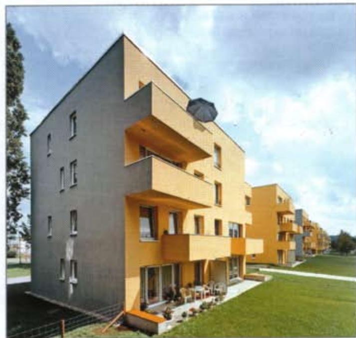
Die Leinefelder Stadtvillen künden vom in der Stadt vor sich gegangenen Transformationsprozeß.
