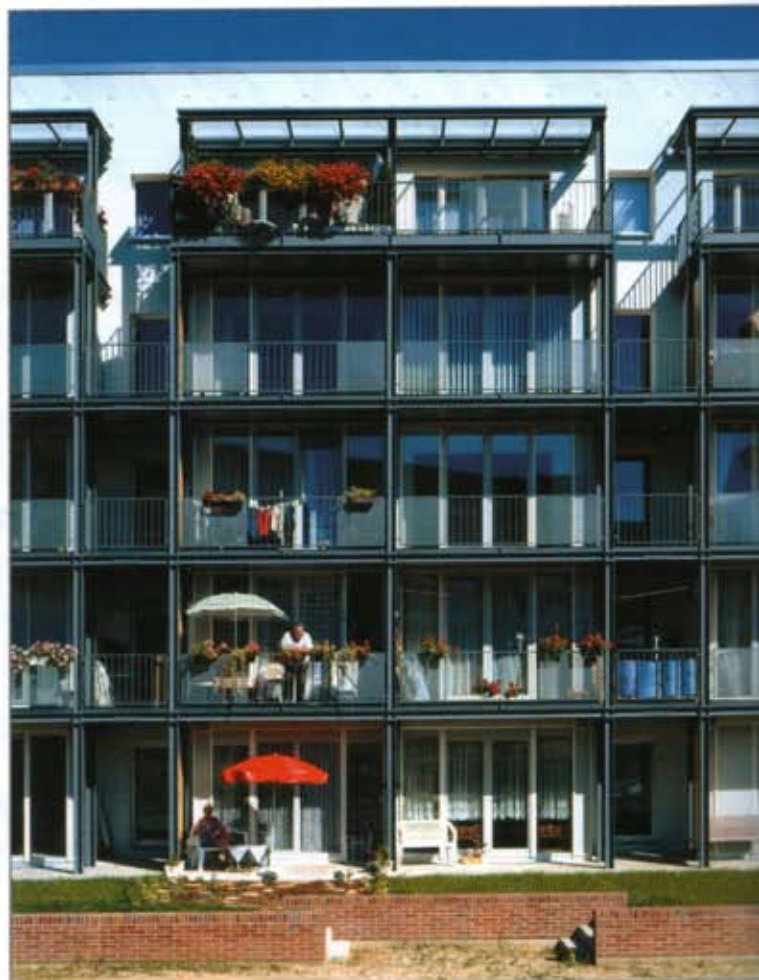
Die Wohnungen in der Leinefelder Lessingstraße erhielten mit einer vorgehängten Stahlstruktur durchlaufende Balkone mit transparenten Brüstungen.
