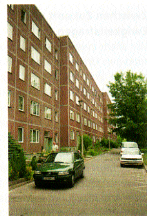
Eingangssseite nach dem Umbau (links); Eingangssseite vor dem Umbau (unten)
