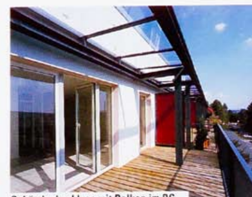
Gebäudeabschluss mit Balkon im DG
