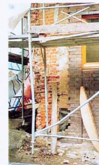
Zusammenführung des neuen Klinkers am südlichen Giebel mit instandgesetzter Klinker- fassade der südwestlichen Seite
