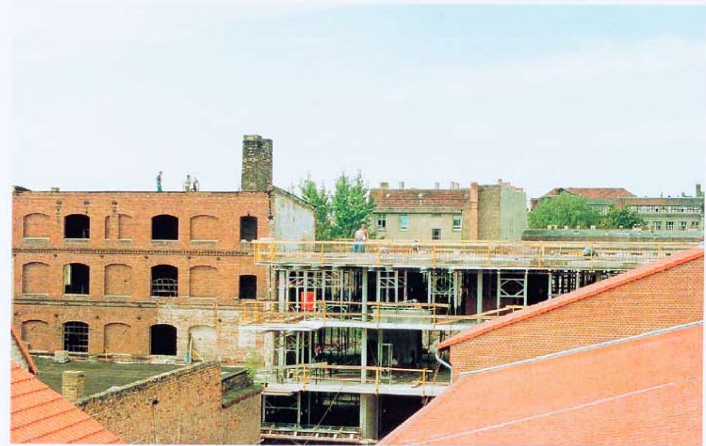
Die Ostseite während der Bauarbeiten
