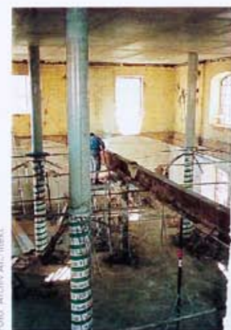
Abriß einer alten Geschoßebene im Altbauteil zum Einbau der neuen Geschoßdecke über 2. OG
