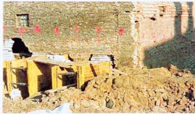
Unterfangungsarbeiten an der Treppenhauswand des alten, integrierten Bauteils der Brauerei
