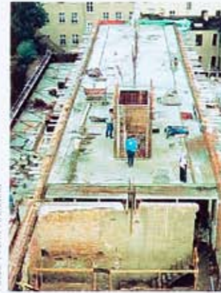
Verbindung Altbau-Neubau während der Bauzeit von oben
