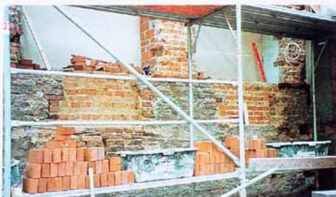
Unterfangungsarbeiten an der Treppenhauswand des alten, integrierten Bauteils der Brauerei
