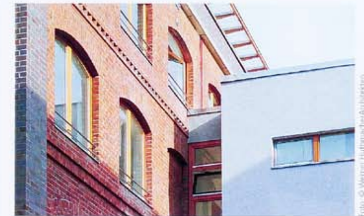
Verbindung Alt-Neu, Ostseite Zentralbau
