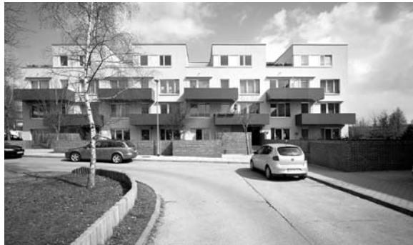
Abb. 1 a, b: Leinefelde, Umbau des Plattenbaus Goethestraße.
